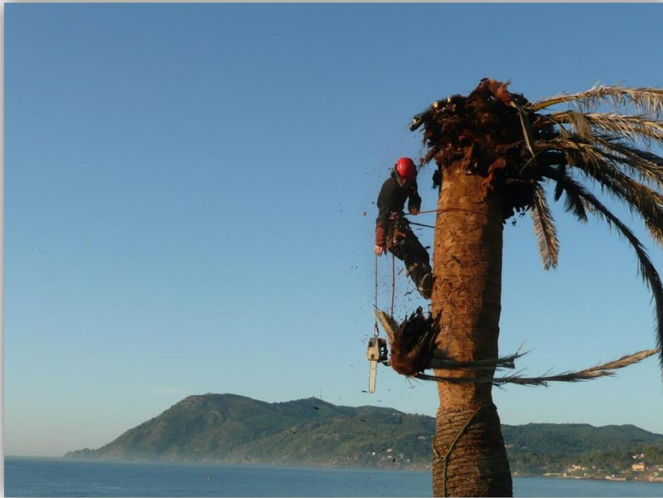
Il arrive parfois que des palmiers se trouvent dans des zones non accessibles aux engins, il faut alors « démonter » le sujet en petits morceaux. Enlèvement des palmes et coupe du tronc en morceaux que l'on descend au sol.
